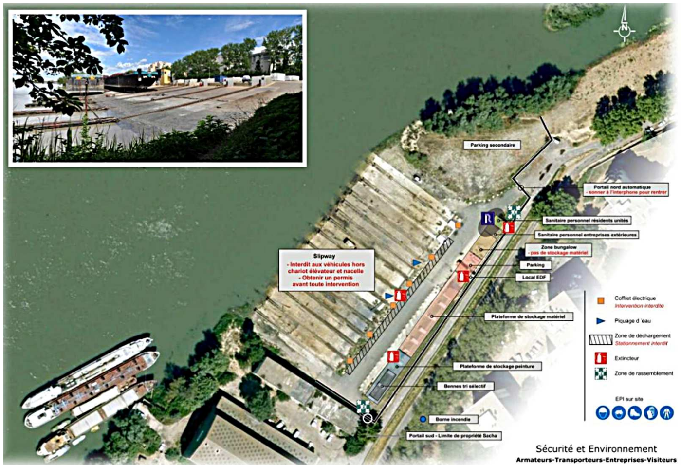
Figure 1 : vue aérienne du site (Source dossier)
